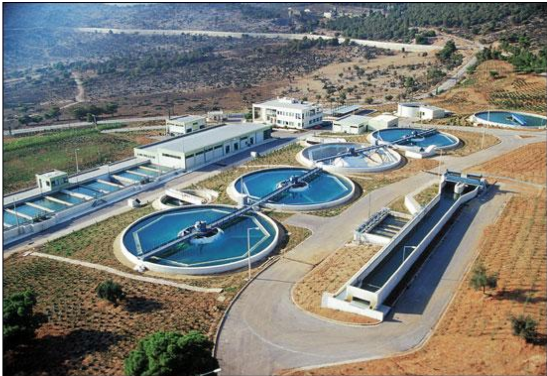
Σχήμα 2.2. Μονάδα Επεξεργασίας Νερού Ασπροπύργου
