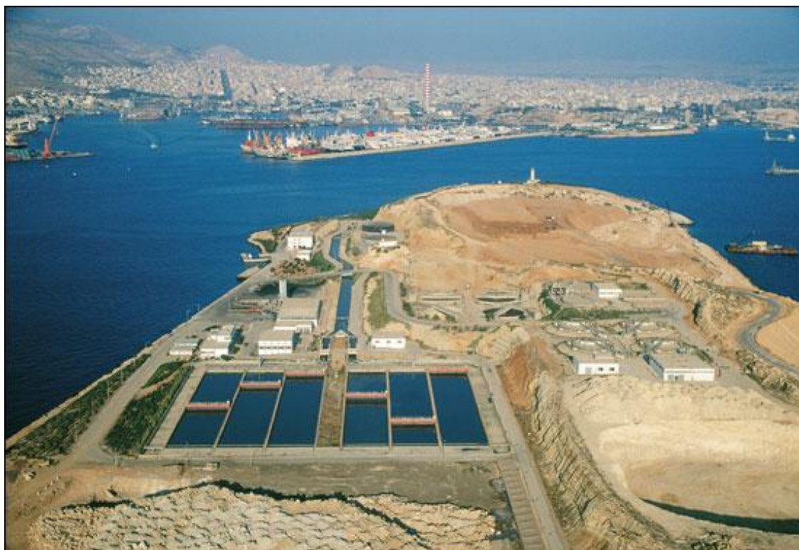
Σχήμα 4.4. Κέντρο Επεξεργασίας Λυμάτων Ψυττάλειας
