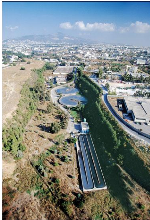
Σχήμα 4.3. Κέντρο Επεξεργασίας Λυμάτων Μεταμόρφωσης (PFR)
