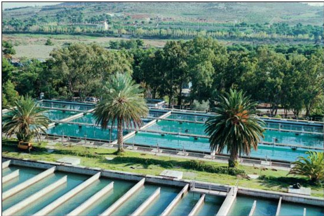
Σχήμα 2.3. Μονάδα Επεξεργασίας Νερού Γαλατσίου
